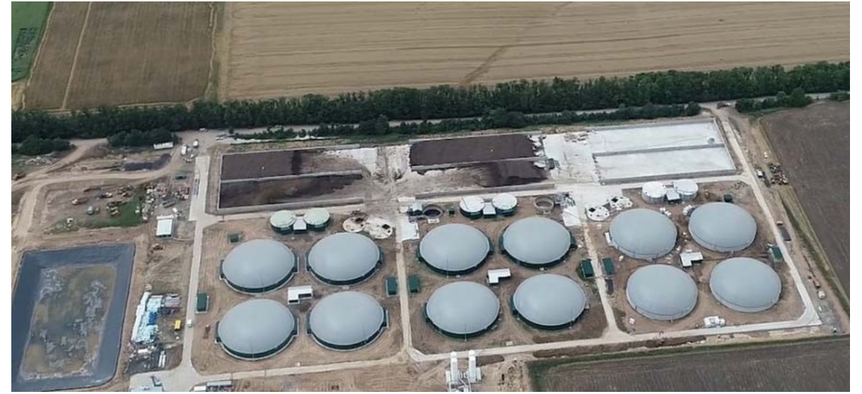
Рис. 8.1. Перша черга біогазової установки на 10 МВт.
