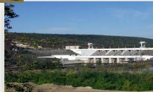
Днестровская ГЭС-1 (702МВт)
