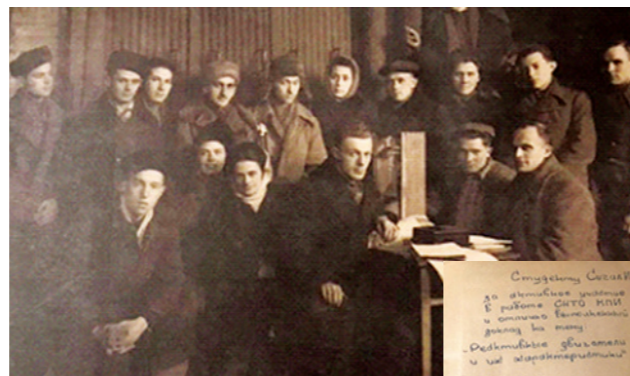
Теплоенергетичний факультет КПІ, 1948 р.
