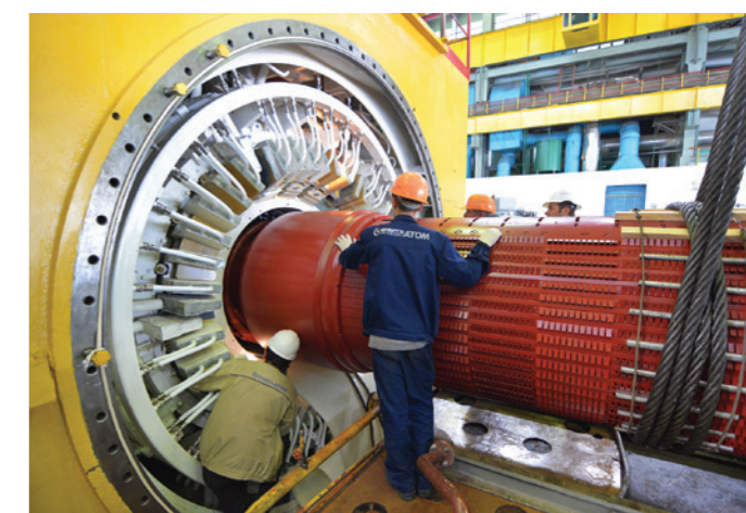
Виконання ремонту турбогенератора ТГ-5
