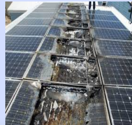
Рис. 2 - Результати пошкодження ізоляції та контактних з'єднань
