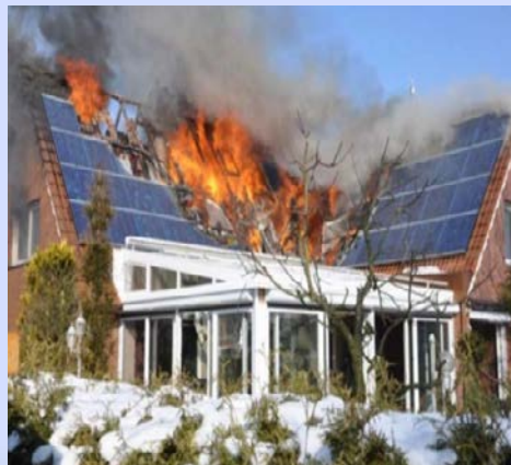
Рис. 2 - Результати пошкодження ізоляції та контактних з'єднань
