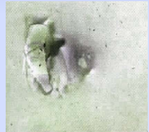
Рис. 6 - Пошкодження EVA (пошкодження етилен-вінілацетатового покриття ФЕМ).
