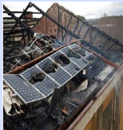
Рис. 2 - Результати пошкодження ізоляції та контактних з'єднань
