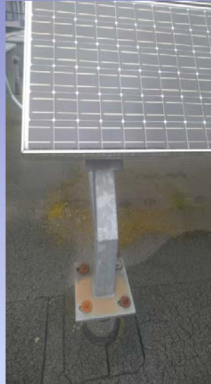
Рис. 1 - Пошкодження каркасу ФЕМ (пошкодження герметика, пошкодження рамки, пошкодження кріплення)
