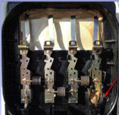
Рис. 1 - Клемний термінал junctionbox – місце можливого перегріву
